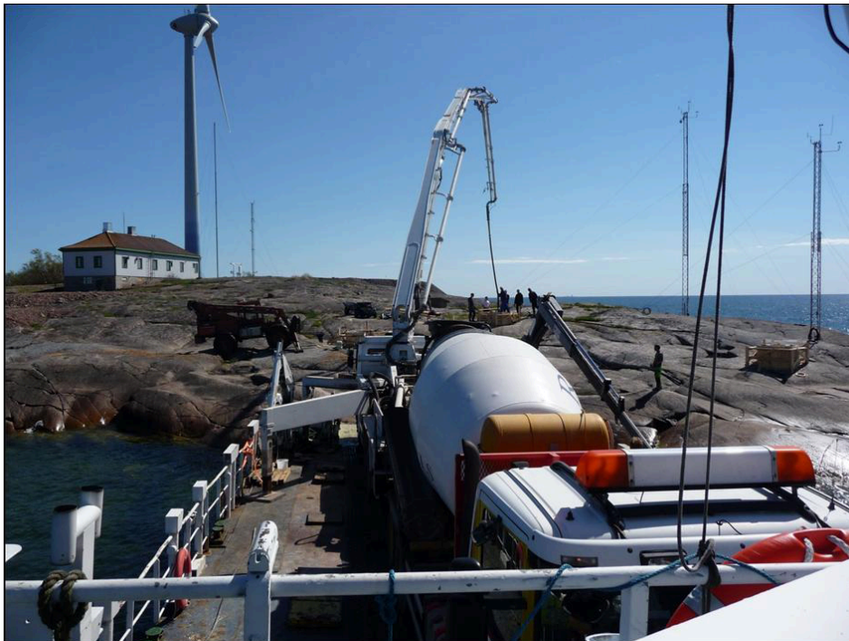
Figur 12. Gjutning av betongfundament på Båtskär. Betongbilen står kvar på pråmen och betongen pumpas via rör till platsen där fundamentet byggs.
