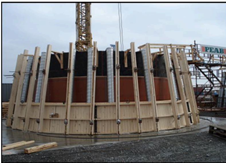
Figur 7. Betongfundamenten prefabriceras på land och transporteras på plats med pråm.
