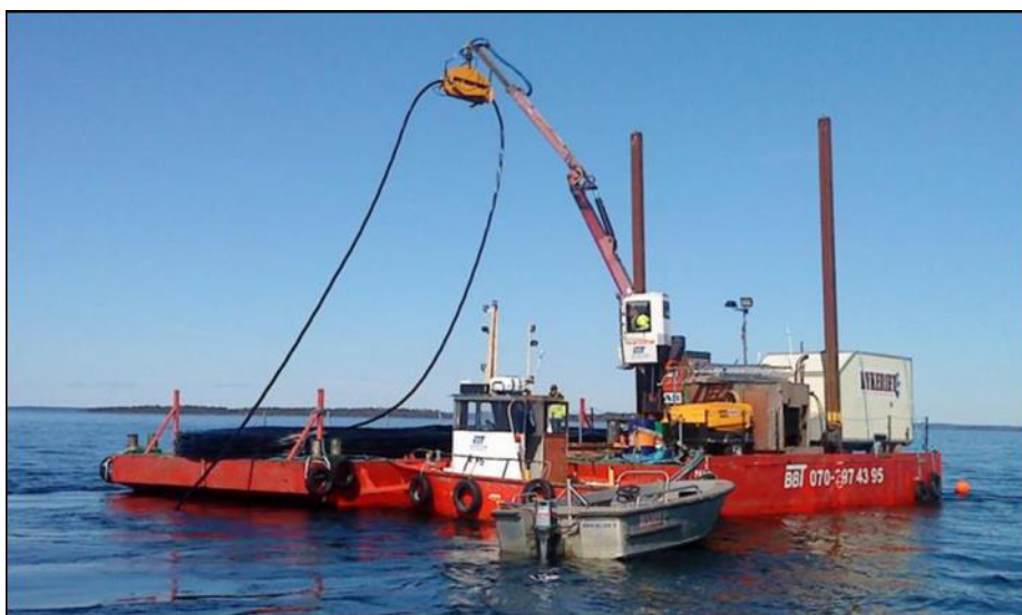
Figur 15. Kabelförläggningen för från pråm eller annat lämpligt fartyg.
