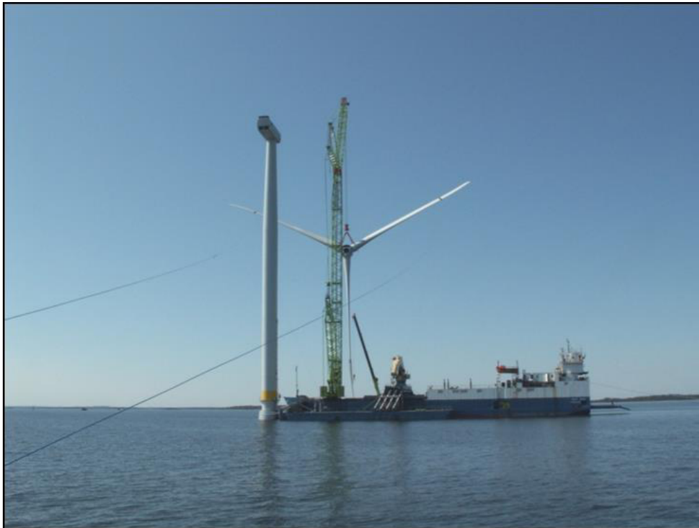
Figur 16. Fartyget Westvind , som användes när vindkraftverken installerades i Vindpark Vänern, kan användas såväl för resningen av vindkraftverken och förläggning av kablarna.
