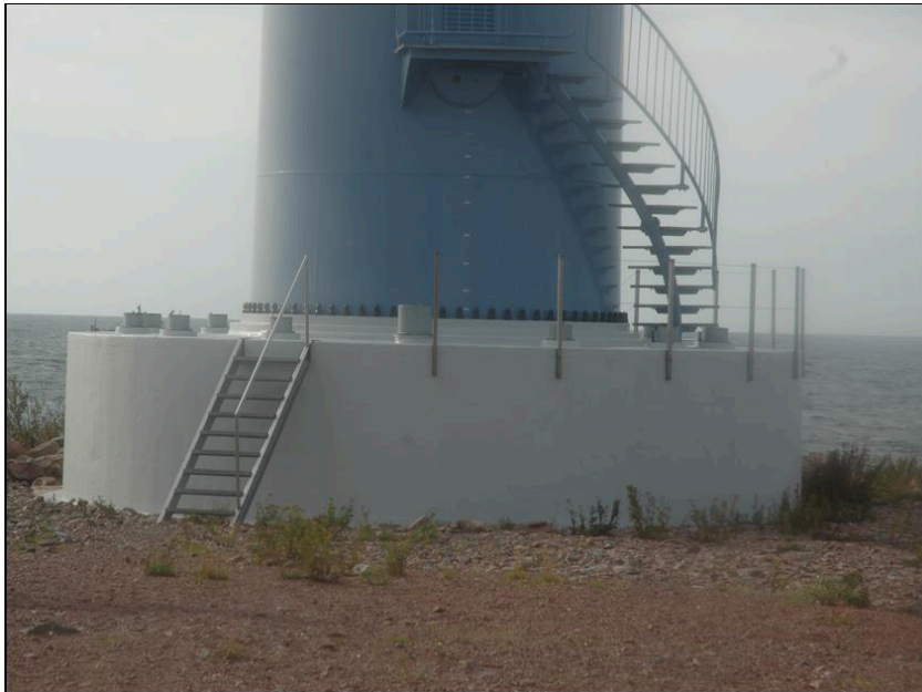
Figur 11. Bergfundament till vindkraftverket Enercon, byggt på Båtskär i Ålands skärgård.
