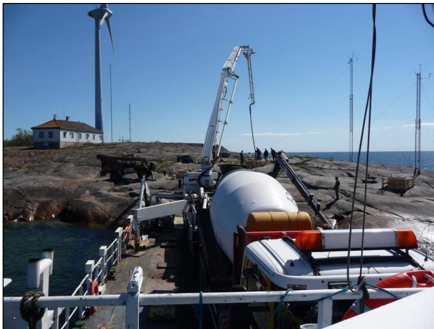
Figur 13. Anläggning av fundament. När vindkraftverk placeras nära stranden kan betongen levereras direkt från en betongbil som står på en pråm. Foto från Båtskär, Åland.
