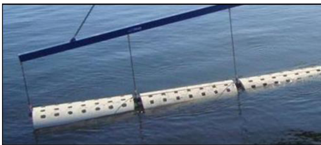
Figur 11. Där kablarna ligger fritt på botten kommer de att viktas med specialkonstruerade betongblock, så att de inte kan sättas i rörelse av vattenströmmar.
