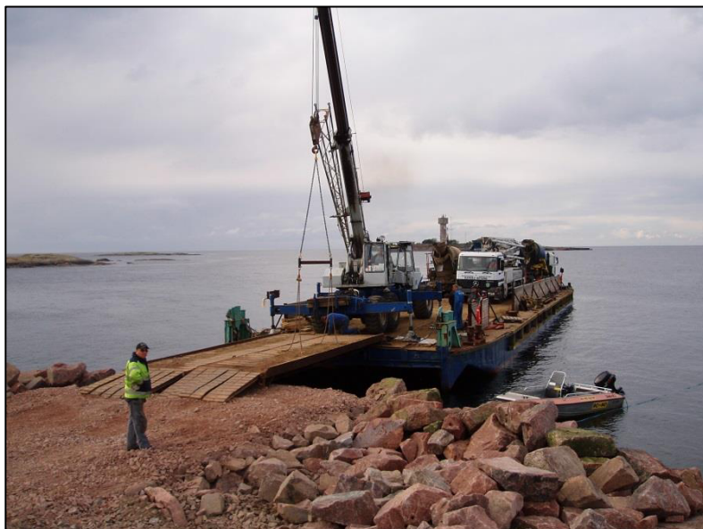
Figur 14. Anlagd anöringsplats med bergkross och makadam för pråm, så att kranar och annan utrustning kan köras i land.
