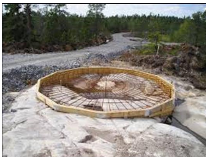
Figur 6. Bergfundament. Denna typ av fundament förankras i berget med stag som är ingjutna i fundamentet och i det underliggande berget, som fungerar som motvikt. Det krävs betydligt mindre betong än till ett gravitationsfundament
